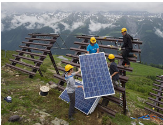
Los paneles fotovoltaicos se pueden instalar en las vallas antiavalanchas. (Keystone)
