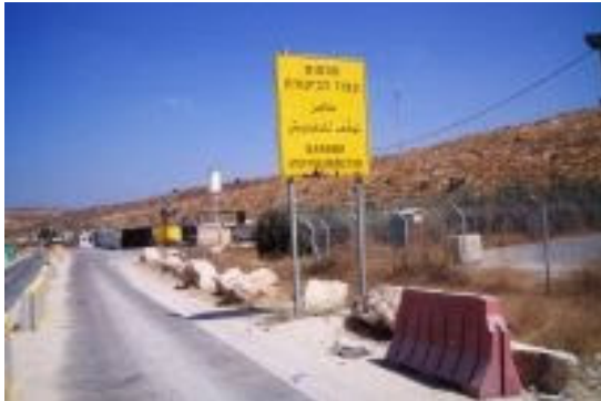
Construcción de rutas ilegales en Palestina Ocupada
