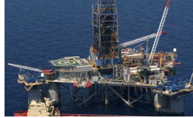
Armado de la plataforma petrolera en Malvinas
