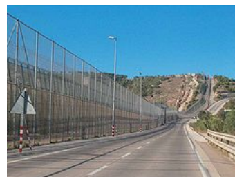
Valla fronteriza en Ceuta
